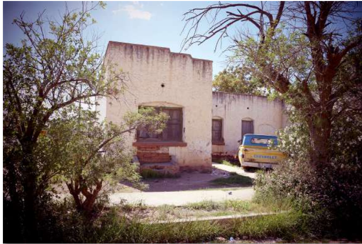
Vista actual de las casas-habitación para trabajadores en la colonia Ávalos. Fuente: Fotografía de Brisa Chávez Zubía (agosto de 2016).
