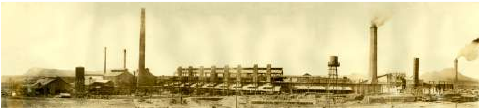
Vista panorámica de la Planta de Ávalos en los primeros años de funcionamiento. Fuente: Archivo personal de Eduardo Uranga en "Ávalos te recuerdo... Smelter life in Ávalos, Chihuahua".
