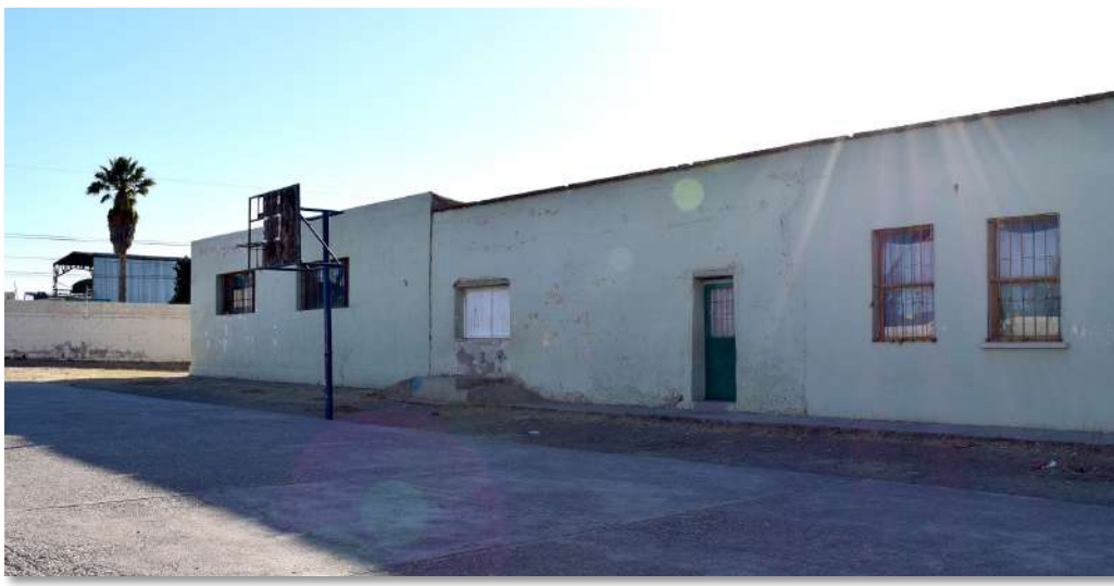
Sección de salones de la Escuela Benito Juárez que aún se conservan como bodegas de la Escuela Zapata. Fuente: Fotografía de Brisa Chávez Zúbia (febrero de 2016).
