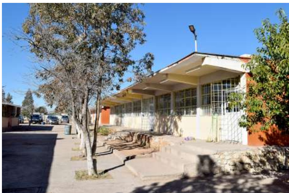
Salones de clases que pertenecieron a la Escuela Gustavo L. Talamantes. Actualmente pertenecen a la Primaria Josefa Ortiz de Domínguez. Fuente: Fotografía de Jesús Adolfo Trujillo Holguín (enero de 2019).
