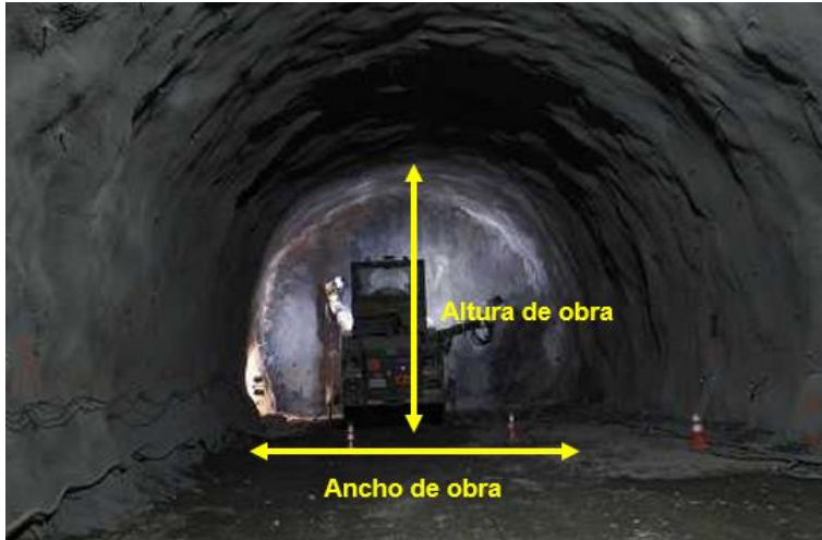
Figura 5. Sección real de una obra minera. Fuente: B2B Media Group SPA ( https://cutt.ly/sb37xOx )
