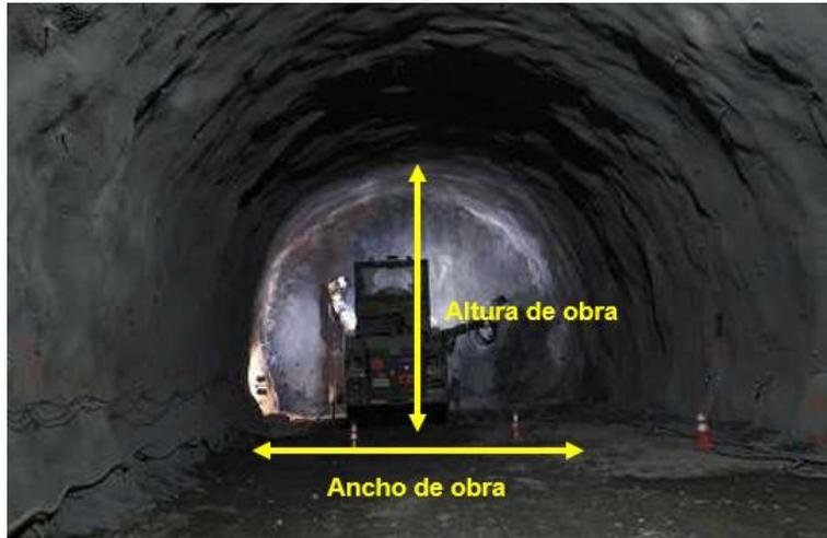
Figura 5. Sección real de una obra minera. Fuente: B2B Media Group SPA (<https://cutt.ly/sb37xOx>)
