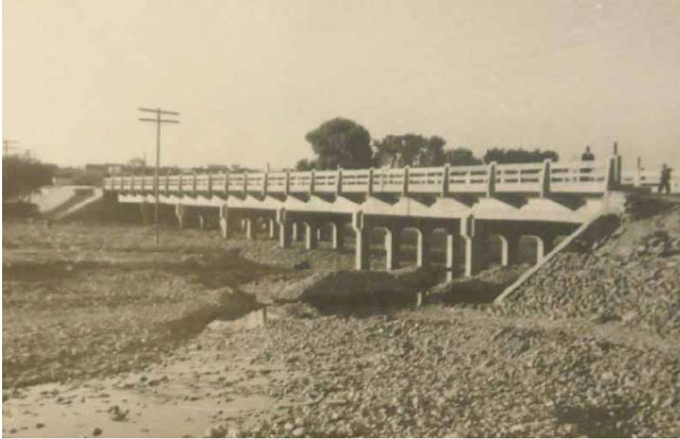
Imagen 3. Obra en construcción del puente del Río Chuvísicar a principios del año 1940.
